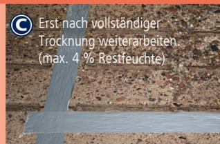
**C** Erst nach vollständiger Trocknung weiterarbeiten (max. 4% Restfeuchte)
