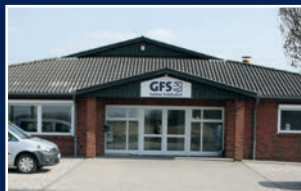
KI station Schillsdorf Ziegelhofer Weg 4 24637 Schillsdorf Tel. +49 43 94 99 10 77 21 Fax +49 43 94 99 10 77 50
