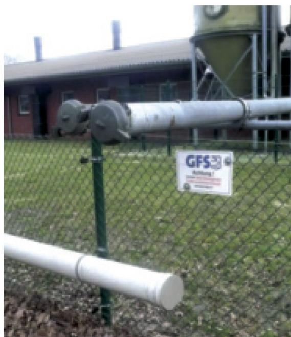
Die Futteranlieferung erfolgt von außen. Das Futter wird durch einen GFS-eigenen Schlauch in die Silos ein-geblasen. Der Schlauch ist in einer verschließbaren Röhre am Zaun angebracht.
