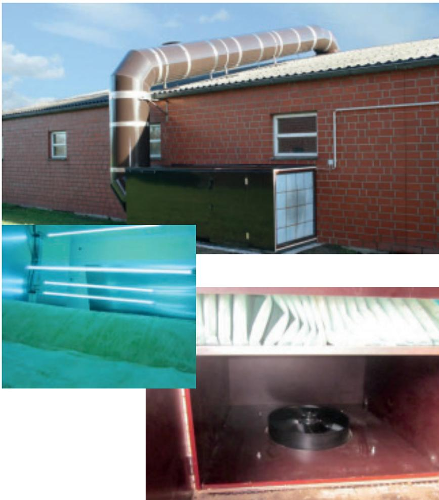
Mit dem System der Überdrucklüftung mit Luftfilter und UV-Desinfektion wird sichergestellt, dass nur gefilterte Luft, die zudem noch mit einer hohen Dosis UVC-Strahlung behandelt ist, in die Ställe geleitet wird. Die UVC-Strahlung bewirkt, dass das Erbgut von Mikroorganismen (Bakterien und Viren), welche die Filter passieren können, geschädigt wird und sie sich nicht mehr vermehren können.
